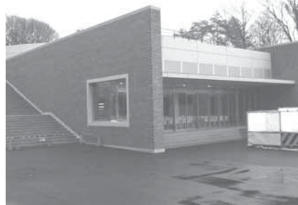
▲【三月に完成したばかりの新厚生棟】
